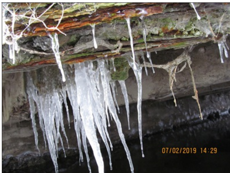
Železobetonová nosná konstrukce : protékání vody, podélná výztuž trámů je silně oslabena korozí
