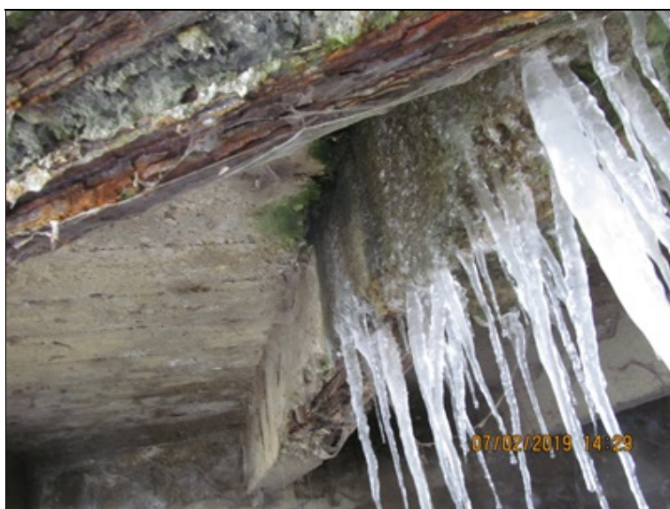
Spodní líc nosné konstrukce : protékání vody, hloubková degradace betonu, podélná výztuž trámů je silně oslabena korozí
