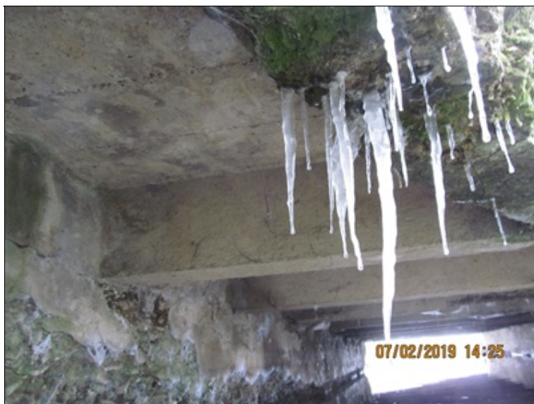
Pohled na OP1 : hloubková degradace betonu, šterková hnízda
