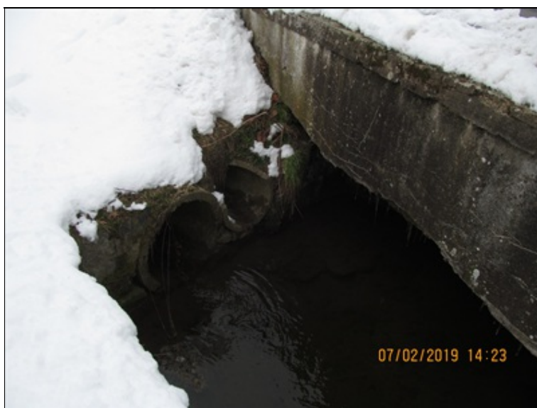
Pohled na most z levé návodní strany. Koryto vodoteče před mostem je zatrubněno rourou o průměru 0,60 m.
