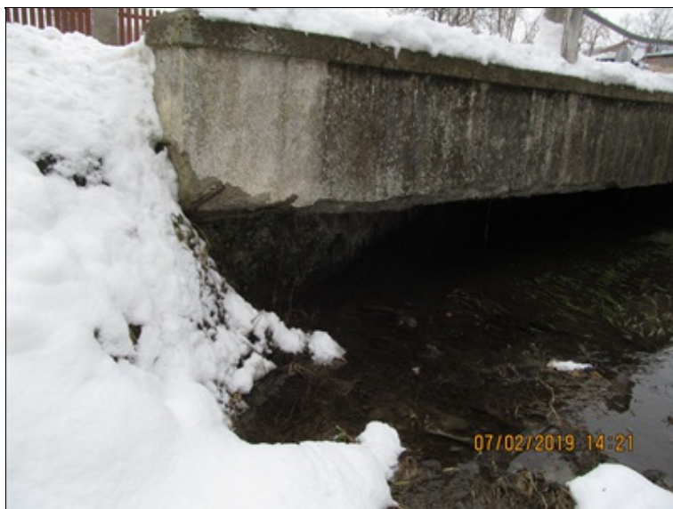
OP1 vpravo : hloubková degradace betonu
