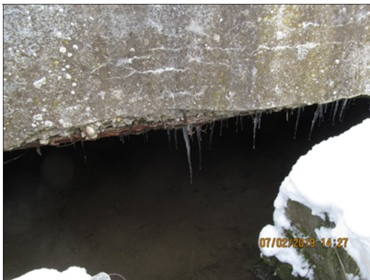
Podélná výztuž trámů je silně oslabena korozí
