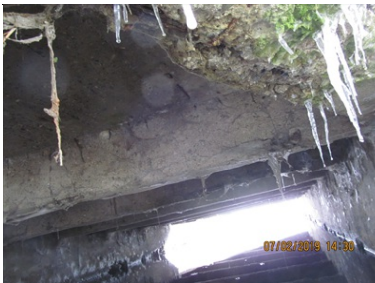
Spodní líc nosné konstrukce : protékání vody, hloubková degradace betonu
