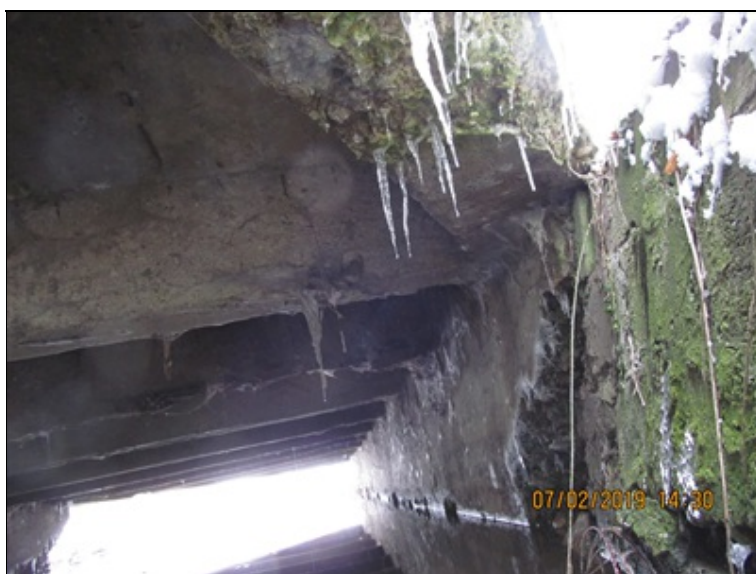
Pohled na OP2 : hloubková degradace betonu, šterková hnízda
