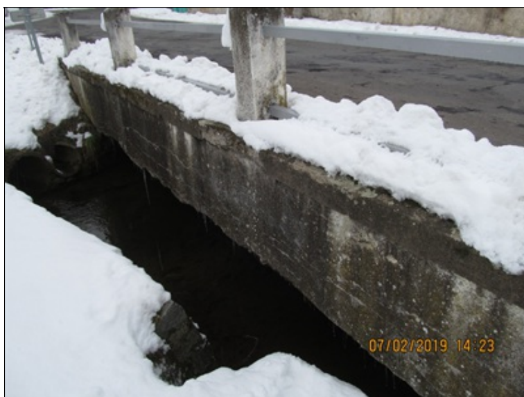
Pohled na most z levé strany. Vodoteč na návodní straně mostu je zatrubněna 1 železobetonovou rourou o průměru 0,60 m
